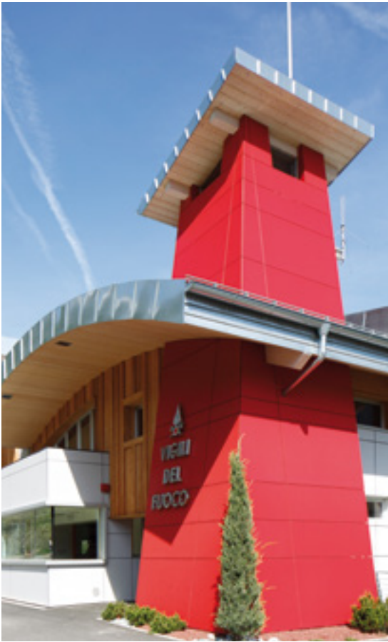
Caserma VVF, Terzolas, Italy/ Ahrntaler Fassaden-Balkone; Photo: Helmut Brunner
