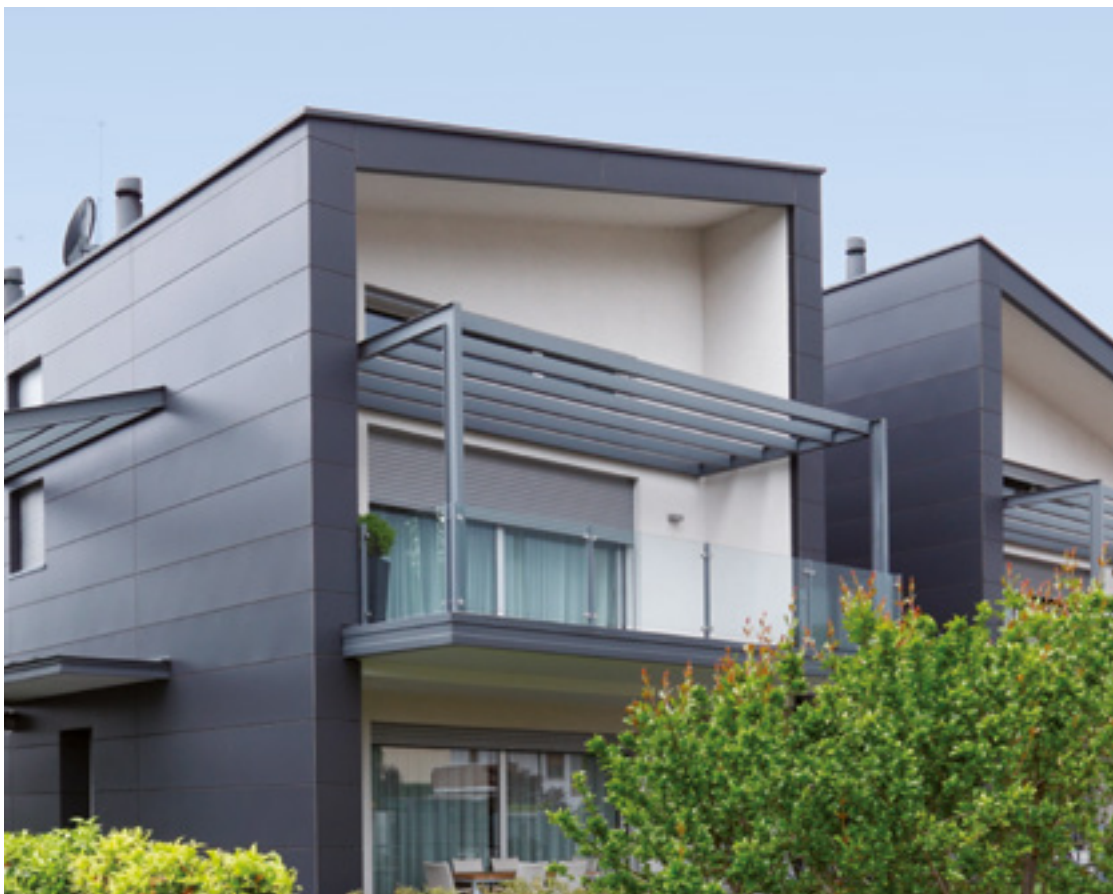
why be normal/ Ahrntaler Fassaden-Balkone
