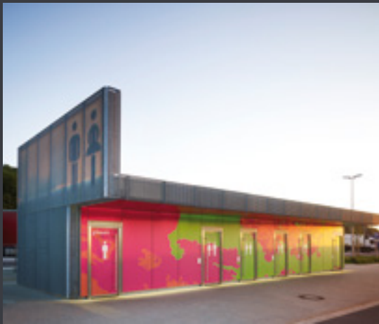
12 RESOPLAN SHOWCASE Parkplatz WC-Anlage, Niedersachsen, Germany
